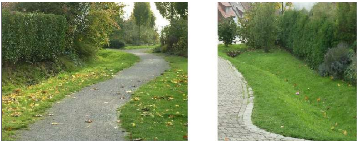
Oberlau: vorbildhafter Grünzug als Wegeverbindung mit Sickergräben und z.T. wasserdurchlässigem Wegaufbau
